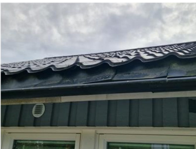
Tak (sadeltak): Fotplåtar delvis olämpligt skarvade
