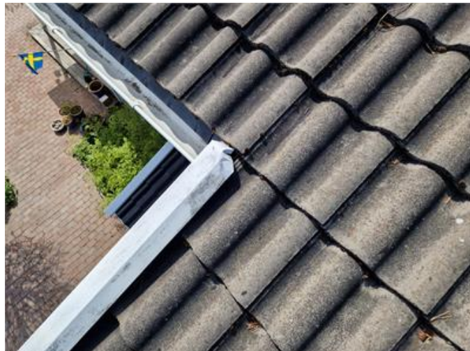
Tak: Otätheter noterades mot kantplåt.
