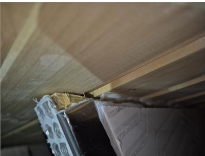
Skiljeväg i duschzon saknar helt eller delvis tätskikt.
