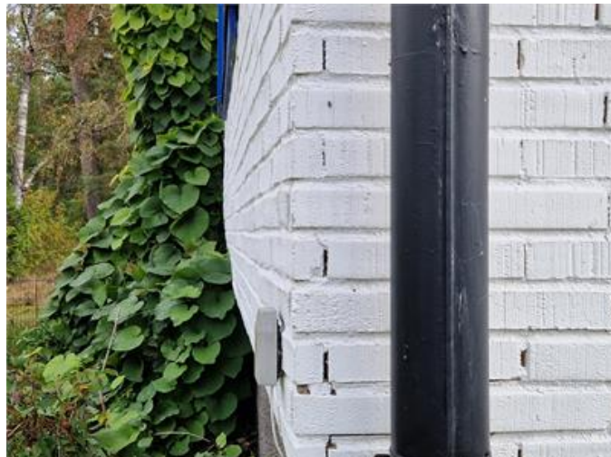
Fasad: Tegelfasad ojämn - båggar delvis.
